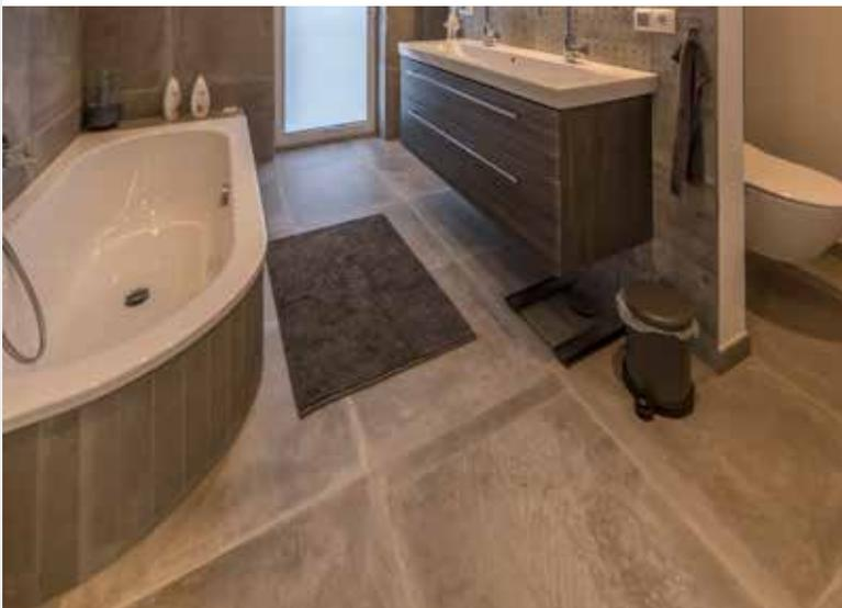
Entsprechend dem Bodenbelag werden Sockelfliesen angebracht, die aus der Bodenfliese geschnitten werden (Höhe ca. 50 – 60 mm). Elastische Fugen als optische Anschluss- und Dehnungsfugen werden mit Silikonwerkstoff versiegelt.
