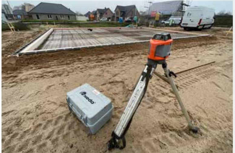
Die Grenzsteine sind rechtzeitig vor Baubeginn von dem Bauherrn anzuzeigen und zu sichern. Das Auswinkeln des Objekts nach den genehmigten Bauplänen des Bauamtes sowie Abstimmung mit dem Bauherrn nach den vorhandenen Grenzsteinen, die Festlegung der Höhen und das Herstellen der Winkelböcke / Schnurgerüst sind im Festpreis enthalten (Feinabsteckung wird durch einen öffentlichen Vermesser durchgeführt).
