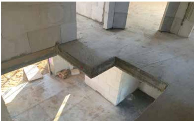
Geschossdecken werden als Massivdecken hergestellt. Die Stahlbetondecken mit einer Stärke von 18 cm werden als Filigrandecke vorgefertigt und vor Ort aufbetoniert und ausgeführt (max. Bewehrung 15 kg/m<sup>2</sup>). Sofern sich aus der Statik höhere Anforderungen ergeben, sind die dadurch entstehenden Mehrkosten vom Bauherrn zu tragen.
