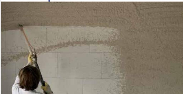
Die gemauerten Innenwände im Erdgeschoss und ausgebautem Dachgeschoss erhalten einen glatt abgeriebenen Gipsputz mit den erforderlichen Eckschutzschienen, Bad und WC erhalten Kalkzementputz. Im Fensterlaibungsbereich werden Anputzschienen angebracht (links, rechts und oben).
