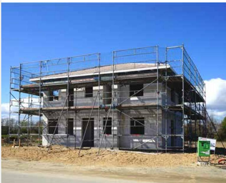
Alle für die Durchführung der Baumaßnahmen benötigten Gerüste werden durch Nissen Massivhaus entsprechend erstellt und bis zur Fertigstellung der Außenputzarbeiten / Verblendarbeiten vorgehalten. Die Arbeits- und Betriebssicherheitsvorgaben der BG-Bau sind zu beachten und einzuhalten.
